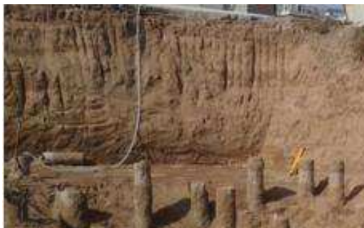
图 1 CFG 桩示意图
