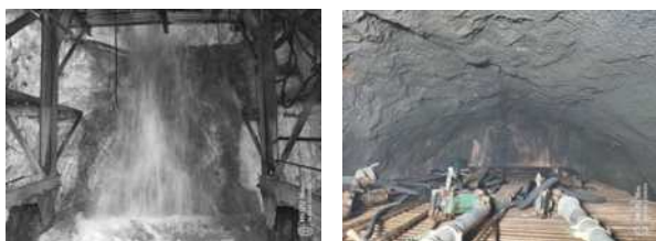
图 1 阿尔金山隧道出口 DK577+355 开挖掌子面
