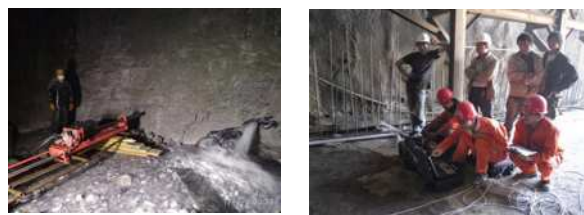
图 2 超前水平钻探施工
