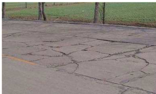
图3 裂缝病害
