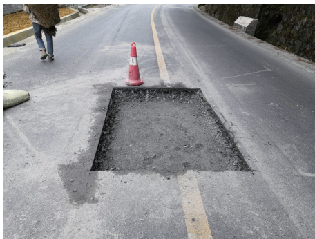
图1 沥青路面裂缝现象
