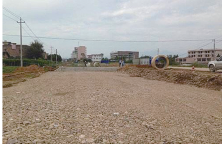
图1 软土地基换填砂砾石
