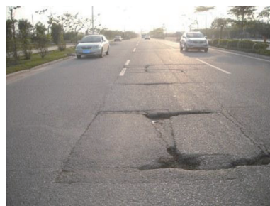
图 1 沥青混凝土路面裂缝图示
