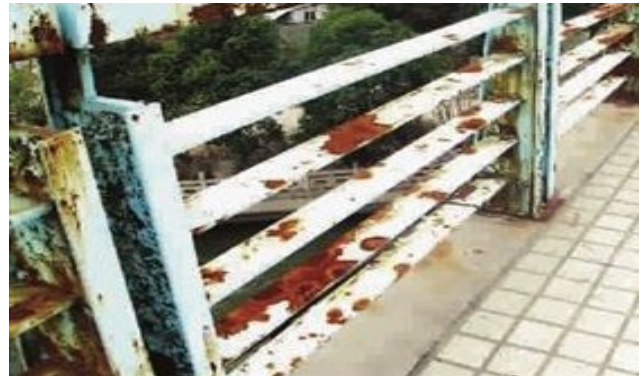
图2 腐蚀的护栏
