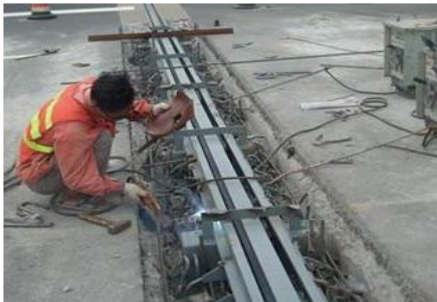
图3 设置伸缩缝
