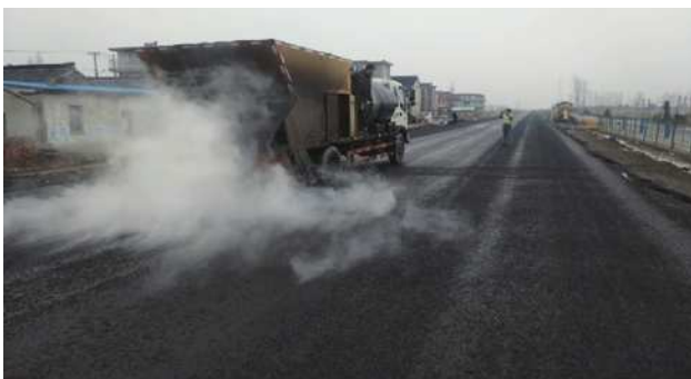
同步洒布车下封层洒布
