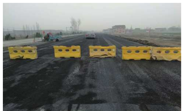
下封层施工后封闭交通进行养护
