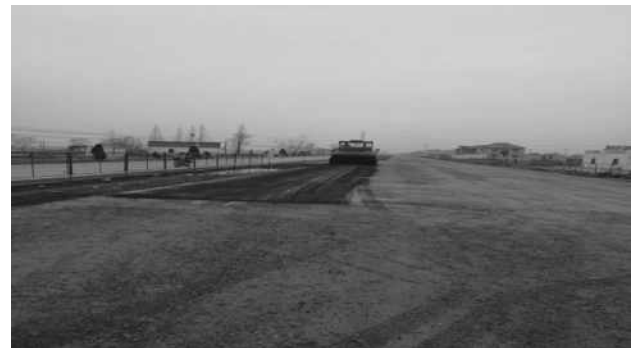
下封层洒布后胶轮碾压
