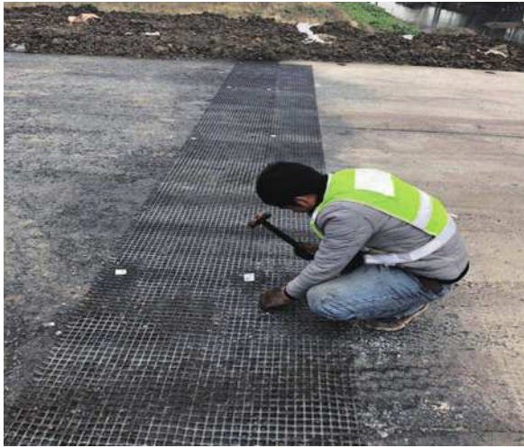
基层裂缝处铺设玻纤格栅
