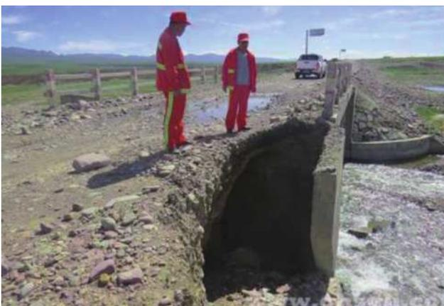
图1 桥涵台背回填施工质量缺陷
