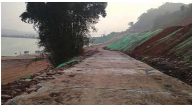
图 6 宽度 4.0m 装配式施工临时道路图
