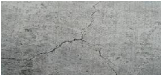
图1 混凝土裂缝
