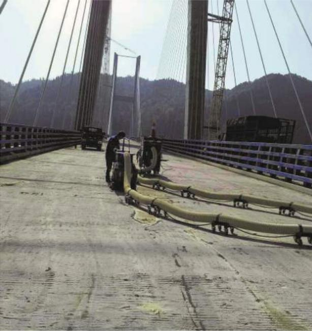
图1 桥面防水混凝土柔性防水层施工
