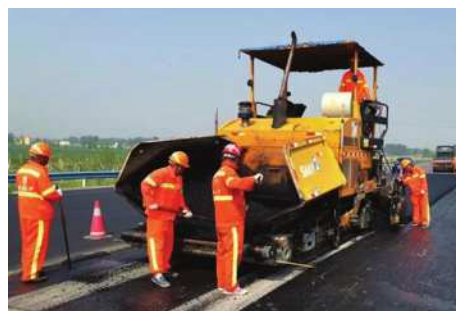
图1 施工设备管理
