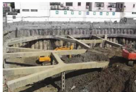
图1 深基坑内支撑梁支护施工过程
