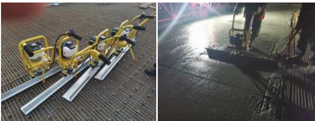
图3 超高韧性混凝土振捣
