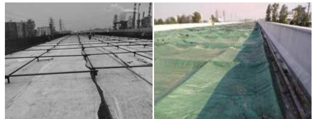
图5 蒸汽养护棚的搭设
