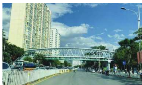
昆明市工人医院新建天桥
