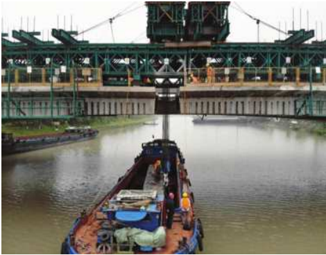
图3 中跨节段下放拆除及块段运输
