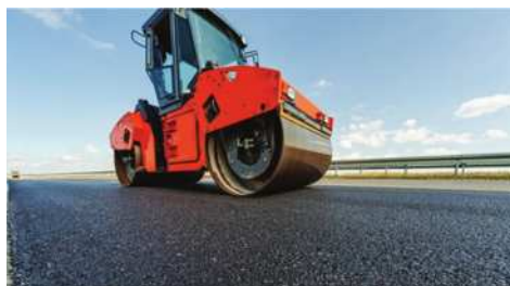
图2 沥青双层摊铺施工
