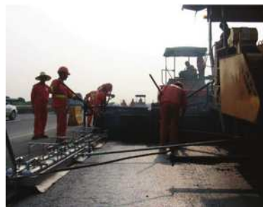
图3 双层摊铺接缝施工处理
