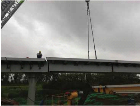
图2 钢箱梁“Z”型端面现场吊装图
