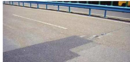
图1 道路桥梁裂缝病害
