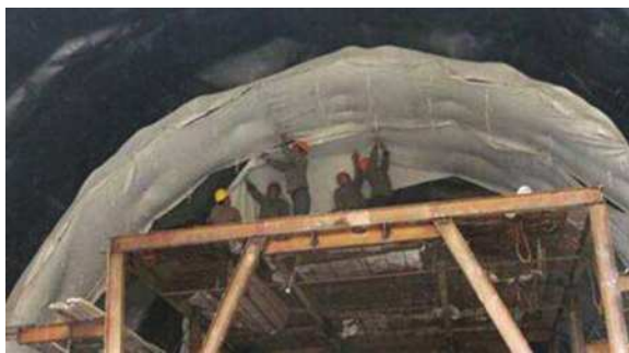
图1 隧道防水层铺设施工
