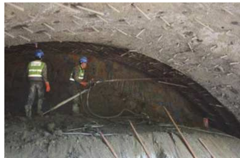
图2 锚杆施工现场图
