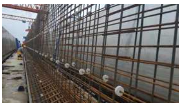
预应力钢筋制梁阶段
