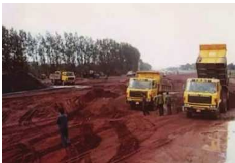
图1 软土地基施工现场
