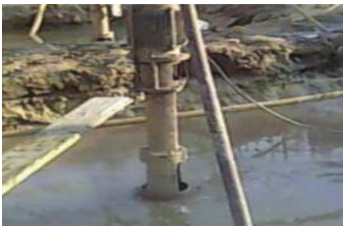
图3 水泥粉喷桩法
