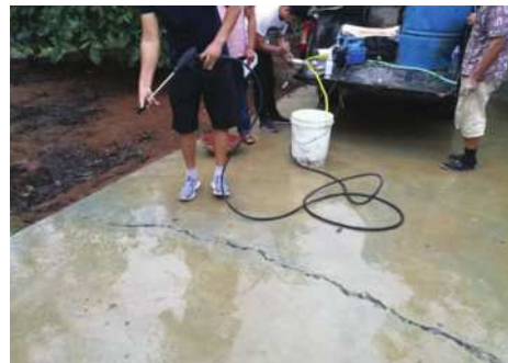
图3 混凝土裂缝处理
