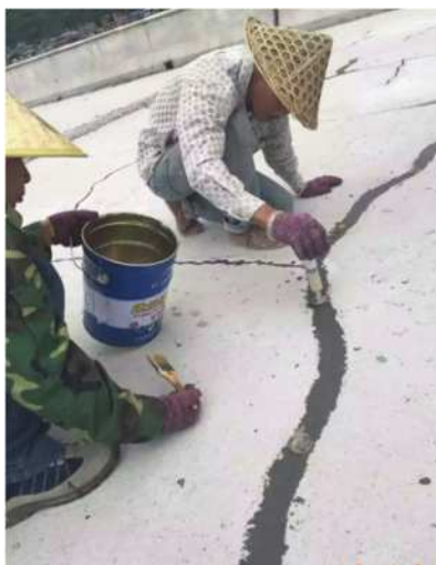
图2 施工人员进行路面裂缝处理
