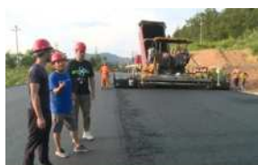
路面压实施工现场
