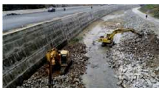
施工现场作业图
