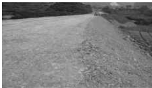
路基填方施工
