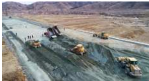
路基填筑施工
