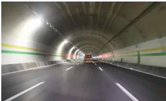
图1 隧道内三车道分隔虚线
