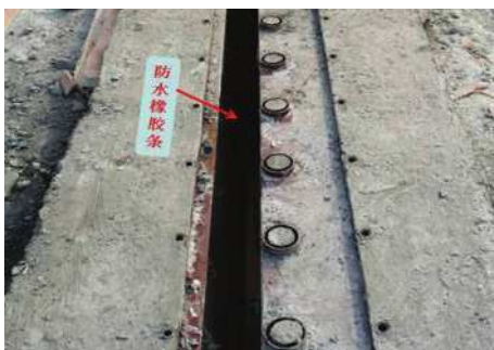
图4 安装防水橡胶条
