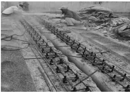
图9 构造筋与桥梁内预埋筋焊接
