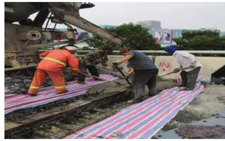
图10 伸缩缝两端浇筑混凝土
