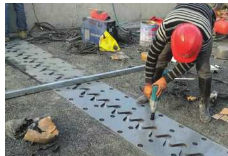
图6 安装主伸缩面板
