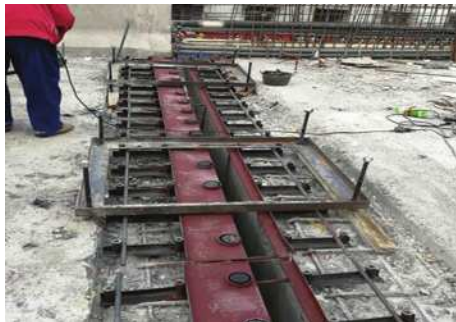
图2 安装预埋组件
