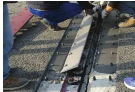
图5 安装丝杆和不锈钢防尘组件
