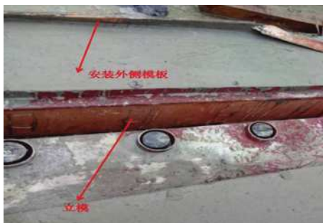
图3 立模、浇筑混凝土
