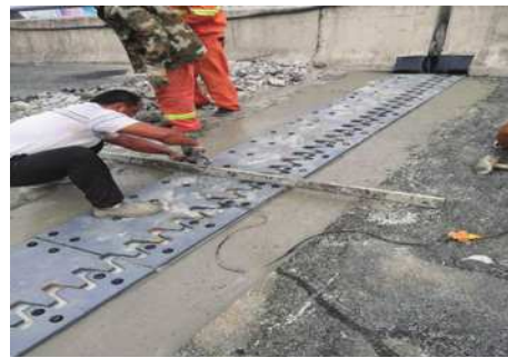
图11 安装伸缩缝主钢板
