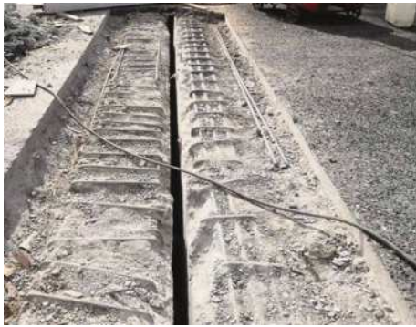
图8 伸缩缝两端凿毛清理干净
