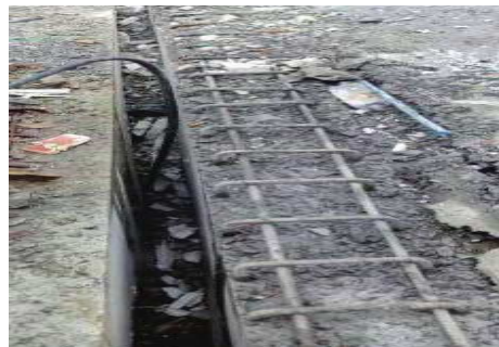
图1 伸缩缝装置安装准备工作
