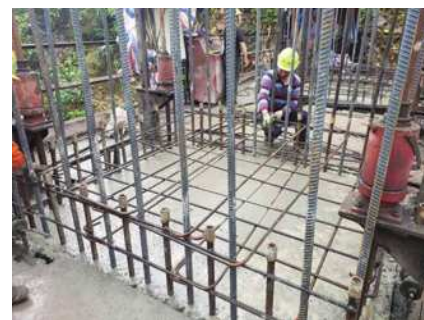
图12 矩形墩混凝土浇筑
