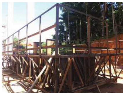
图3 滑模围圈桁架图
