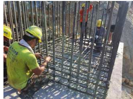
图11 矩形墩钢筋安装
