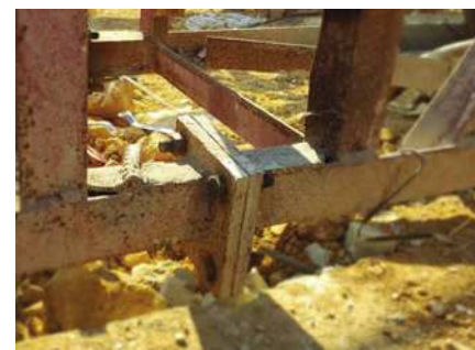
图5 滑模系统连接
