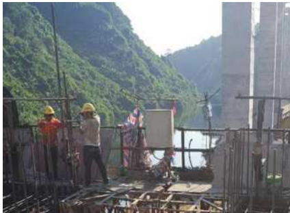
图9 支撑杆焊接
