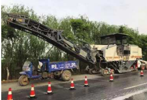
图1 公路微表处施工图
