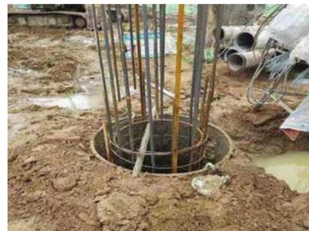
图3 钢筋笼施工图
