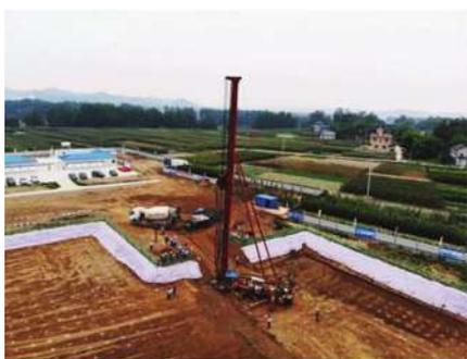
图1 钻孔灌注桩施工图
