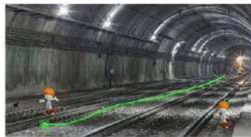
图一 隧道施工
