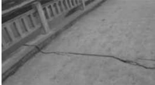
图1 公路桥梁裂缝
