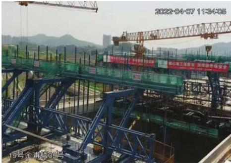
监控挂篮结构内部变形程度、温度情况、
