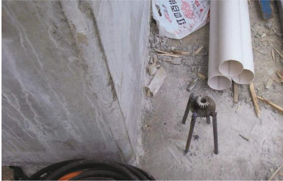
图4：激光垂准仪基座安装支架
