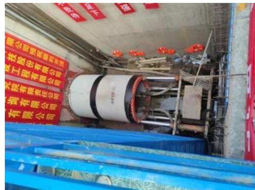
图6 顶管顶进
