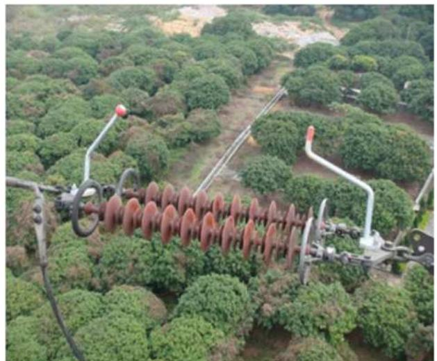
图 1 并联间隙现场图片
