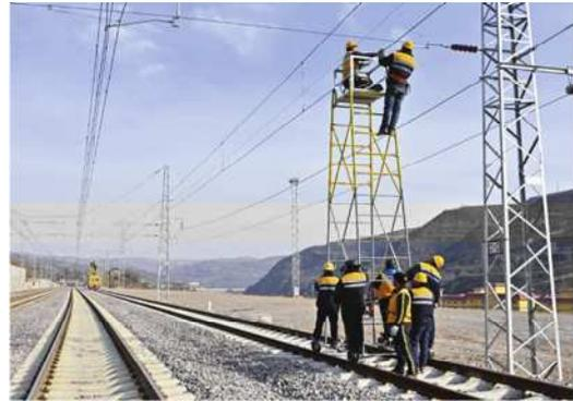
图1 某地接触网维修队全面检查接触网设备
