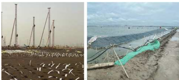
图3 天津南港预压排水现场
