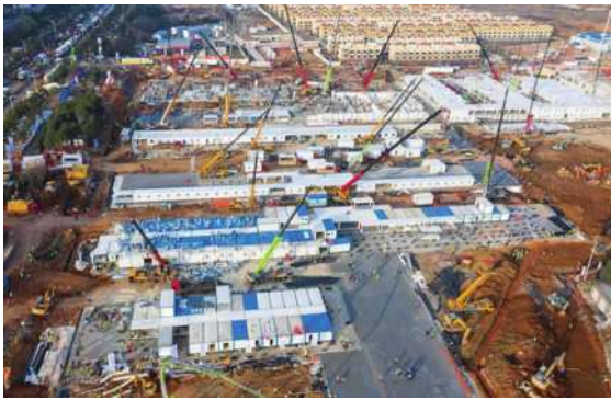
图1 武汉火神山医院建造现场
