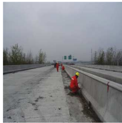
图1 桥梁防撞墙开裂修补施工图
