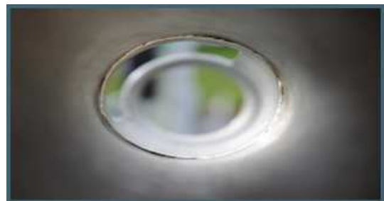
图1 管道内部图片
