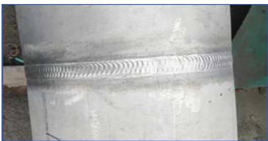
图3 焊口完成图片
