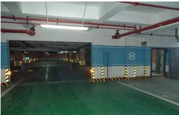
图一 地下室人防建筑
