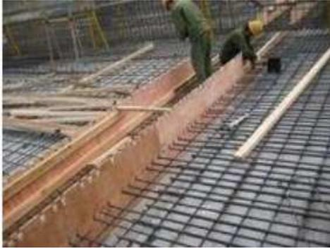
图1 现场后浇带施工作业活动图示
