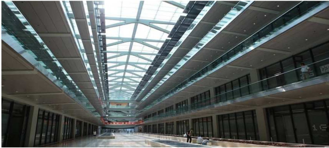
图1 无锡某大型商场消防工程
