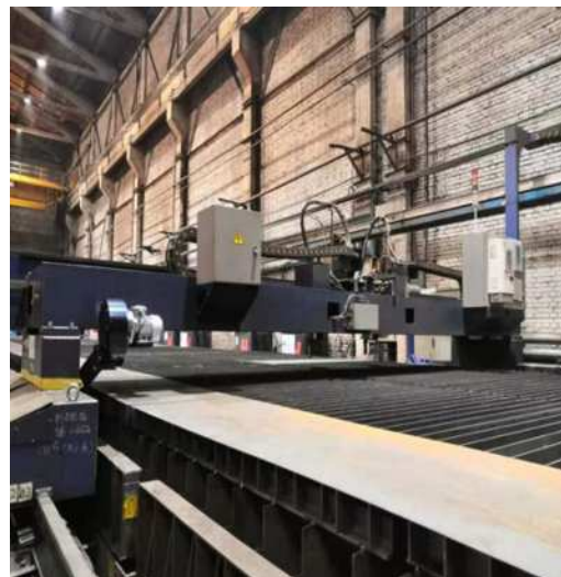
图 3 在机床非工作区铺设钢板提高密闭性
