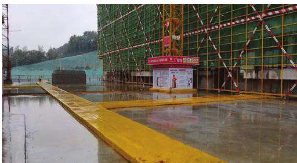
图2 后浇带塔吊防护
