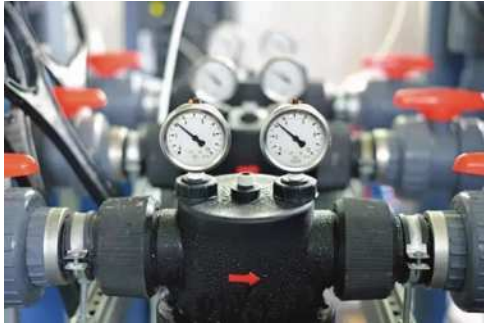
Solvay排水装置
