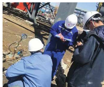
管道试压工作现场
