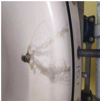
图14 位置4半通型放电通道
