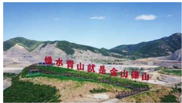
图2 中冶沈勘三河东部矿区矿山地质环境治理工程五期项目现场
