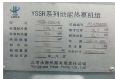
图 2 地源热泵铭牌
